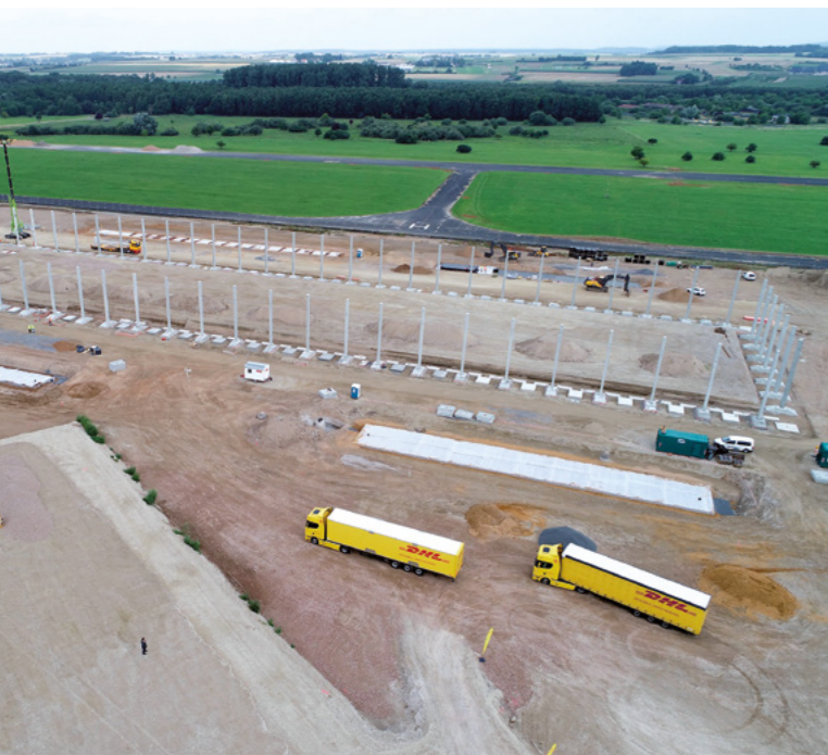
▲ Das Logistikzentrum zu Baubeginn Foto: DHL
