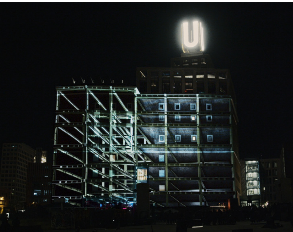
▲ Mapping ist mehr als Projektion, es spielt mit der Architektur und dem Wesen des Gebäudes. Foto: kiU
